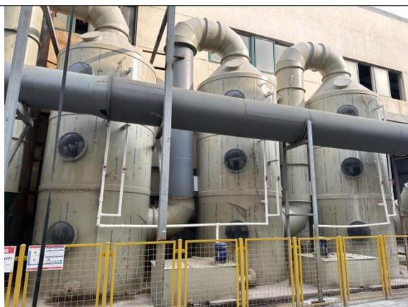
DA001 脱硫脱硝处理装置
